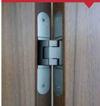
Detail skrytého pantu
